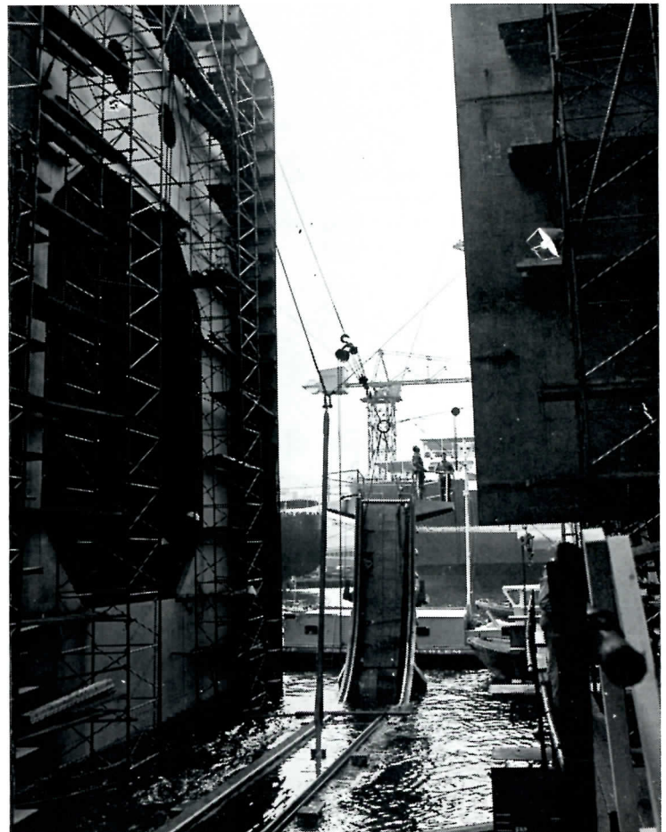
Het neerlaten van de caisson.
